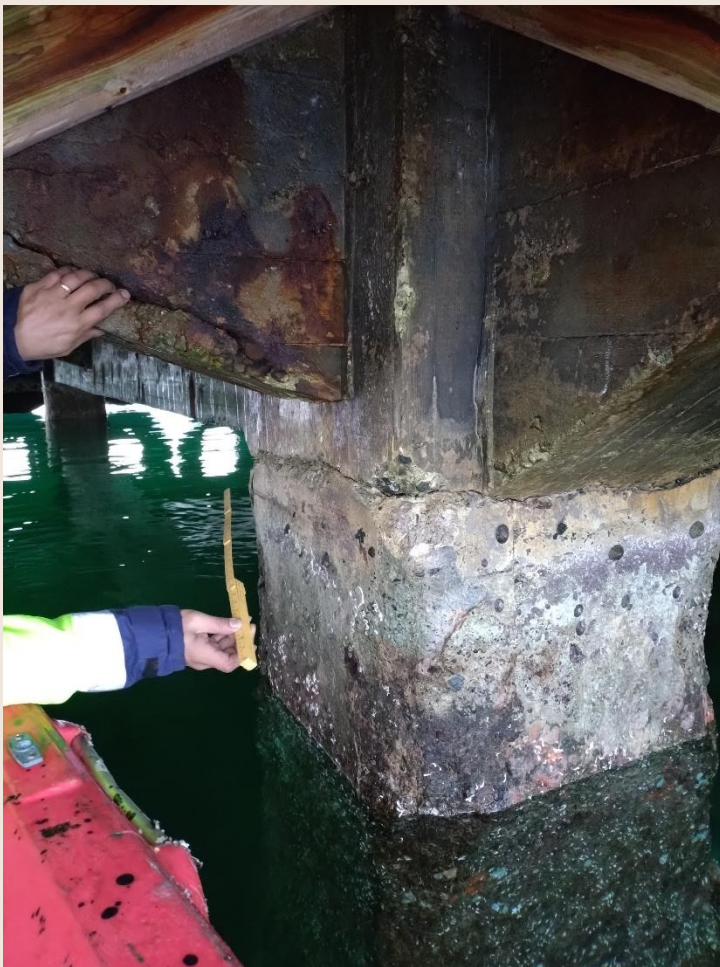
Figur 10: Typisk tilstand betongsøyle
