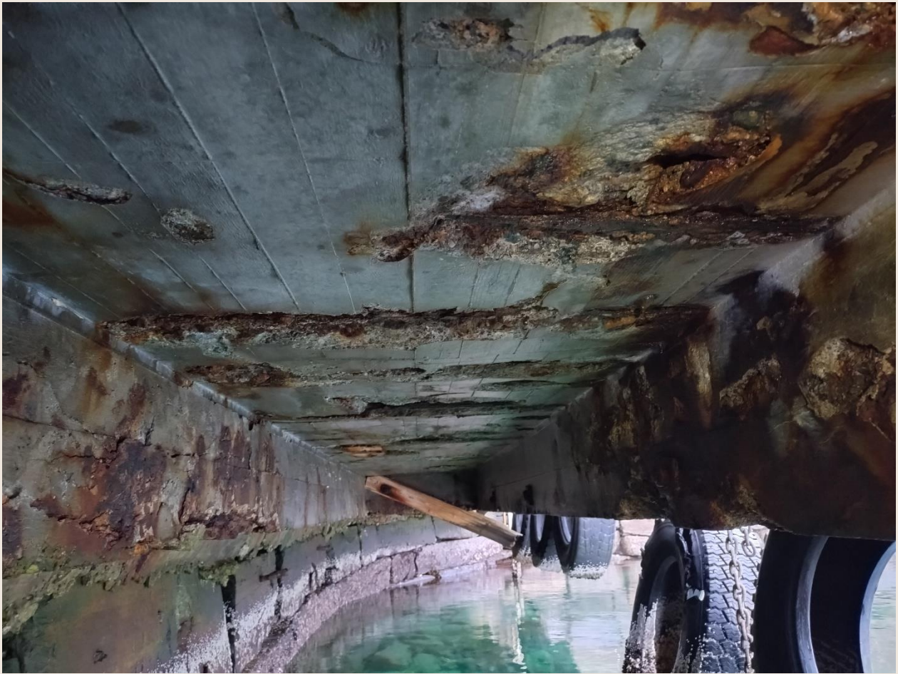
Figur 10: Typisk tilstand nordside, utkraget 160cm.
