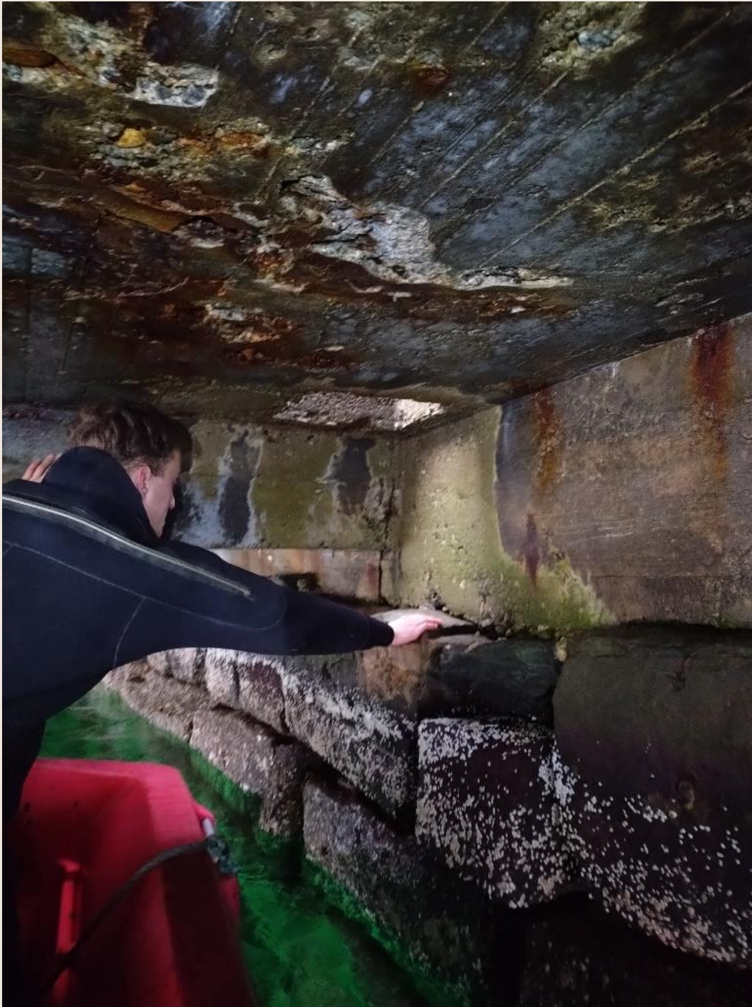
Figur 8: tilstand mot gammel steinkai. Bom i dekket, men bjelke mot steinkai har ikke like omfattende skader (god tilstand på bjelken i bildet).
