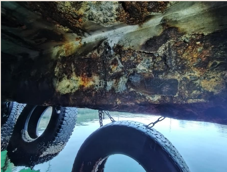
Figur 6: Tilstand Fenderskjørt
