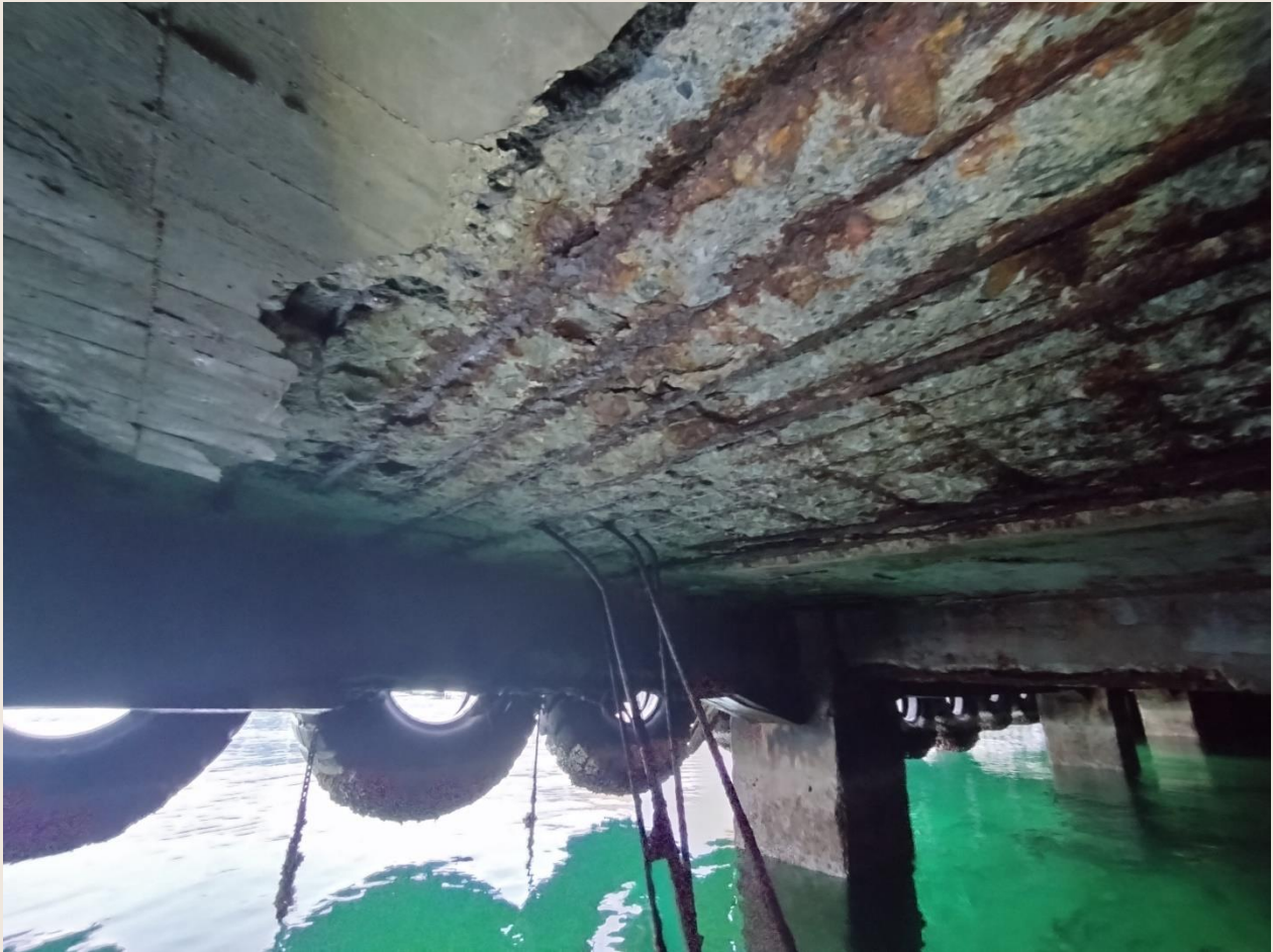
Figur 7: tilstand underkantarmoring – rustet over eller svært vesentlig tverrsnittreduksjon.
